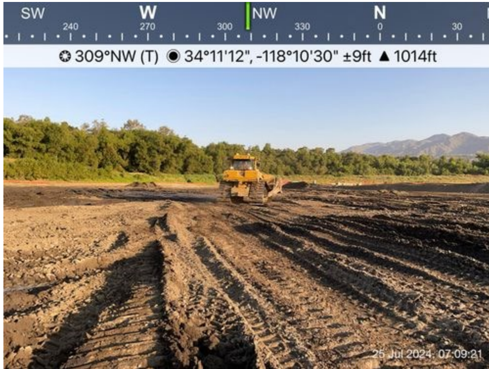
D8T_dozer_moving_sediement.jpg
