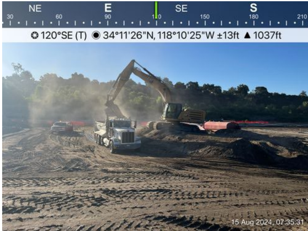
ExcavatorLoadingHaulTruckWithSediment.JPG -118.173775 34.190641666666664
