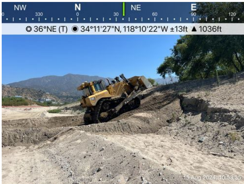
DozerFillingErodedSlope.JPG -118.17282222222222 34.190891666666666
